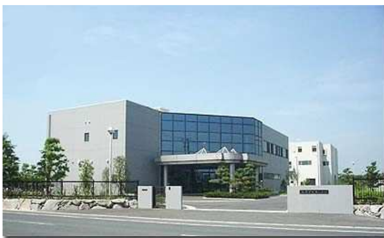
図 4.1.3 旭市上下水道お客様センター(旭市浄化センター)
