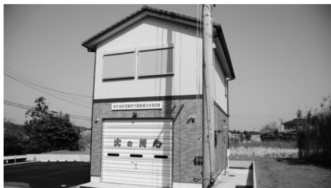
地域の防災拠点となる消防庫
