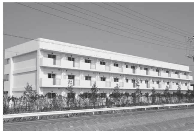
入居が始まる災害公営住宅
