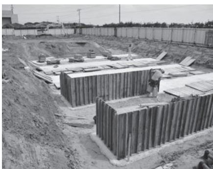
工事が始まった現場
