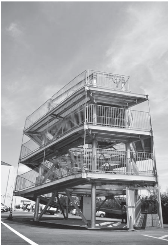
津波の威力を緩和する六角形構造の避難タワー（飯岡体育館駐車場）
