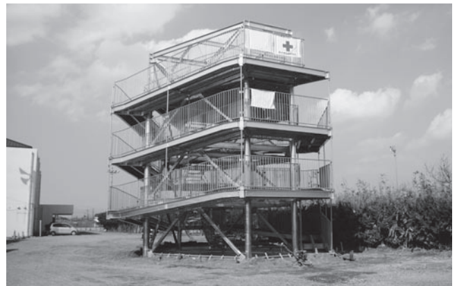
津波避難タワー(三川地区)
