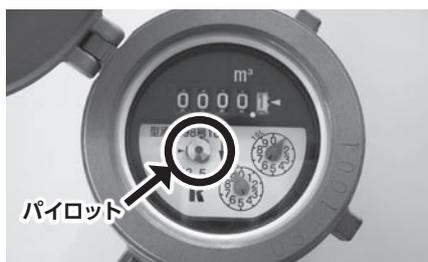
3 パイロットが少しでも回っていれば、どこかで漏水しています。漏水箇所を確認して早急に修理しましょう。
