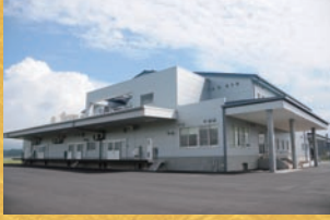
4位 / 旭市第二学校給食センター
