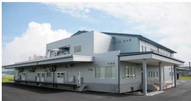
完成した旭市第二学校給食センター
