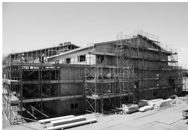
建設が進む(新)第二学校給食センター
