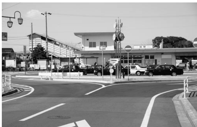
整備が進む旭駅前広場
