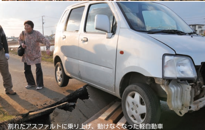
地面が沈下、地中から砂が噴き出た跡
