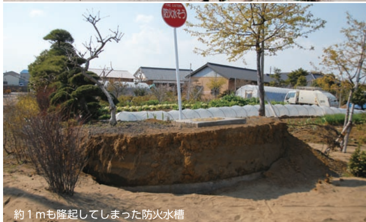
地面に大きく亀裂が入った干潟中
