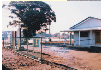
▼埴新町区民館に設置されたフェンス
