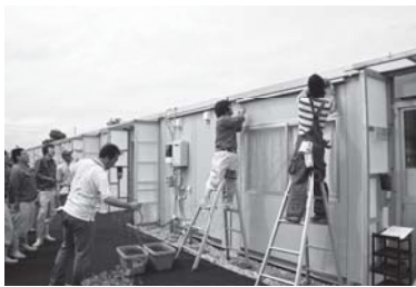
協力しながらの設置作業(仮設住宅旭)
