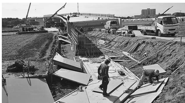
▲建設が進む旭中央病院アクセス道
