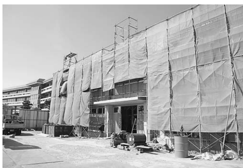
▲改築中の第一中学校屋内運動場
