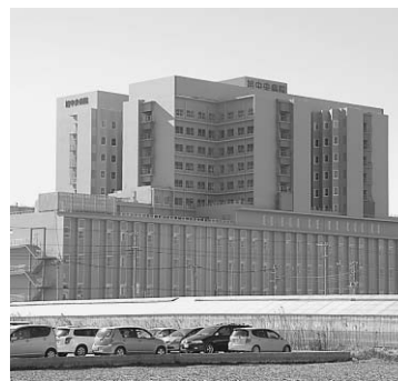
▲旭中央病院新本館
