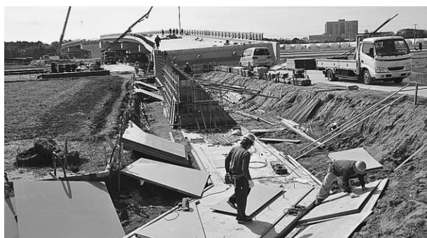
▲建設が進む旭中央病院アクセス道
