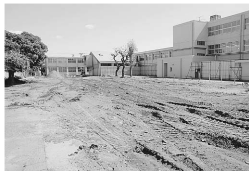
▲旧校舎の解体が終わり新校舎の着工を待つ中央小
