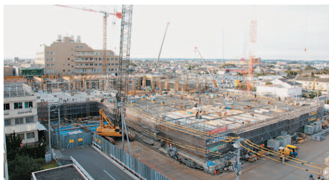
▲工事が進む中央病院
