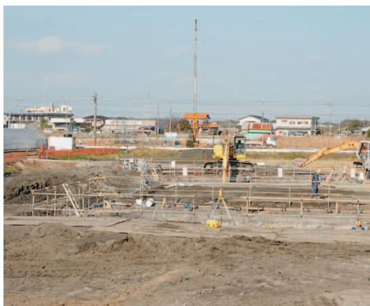
▲着々と進められる架橋工事（12月）
