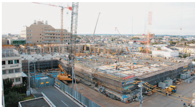
▲工事が進む中央病院
