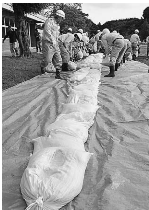
▲積み上げられていく土のう
