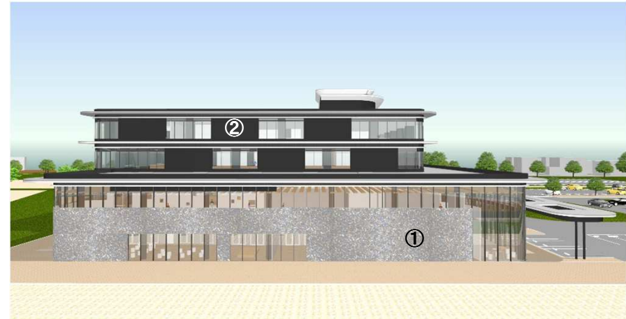
外部仕上げ(仁玉川側)
