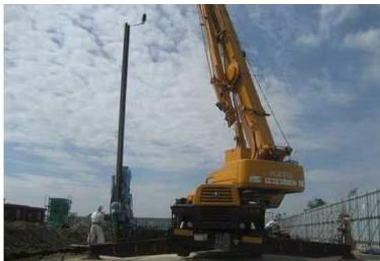
掘削による地盤の崩落を防止するため、鋼製の矢板を打ち込んでいます。
