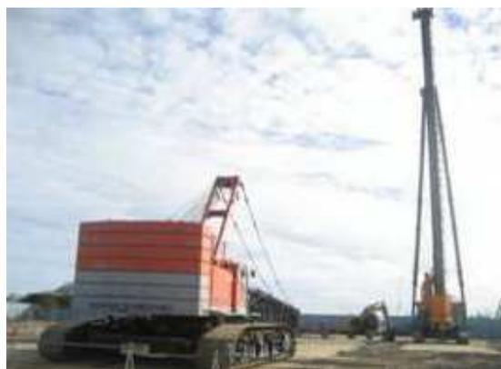
杭基礎工事に使う機械（写真右側）を組み立てています。
