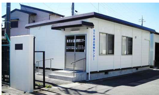
図 4.1.3 旭市水道お客様センター
