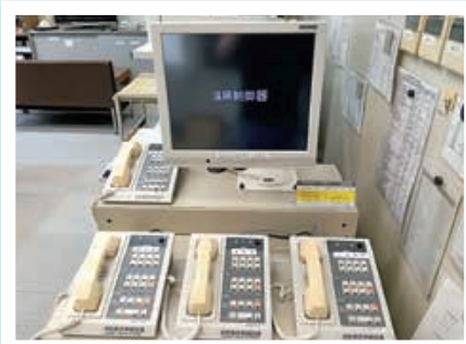
旭市消防本部に設置、出動隊との無線交信に使用します。
