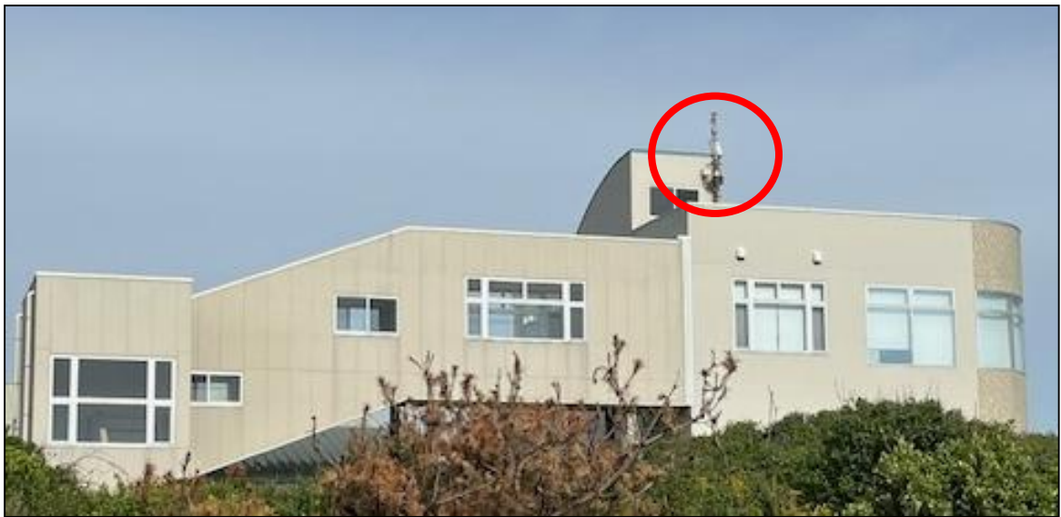
ライブカメラ設置箇所の現況写真(旭市ライブカメラ撤去前)
