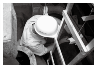
問題箇所を修理
