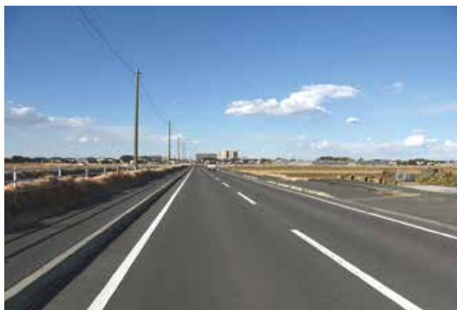
震災復興・津波避難道路（椎名内西足洗線）
