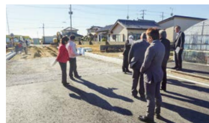
飯岡の津波避難道路整備を視察
