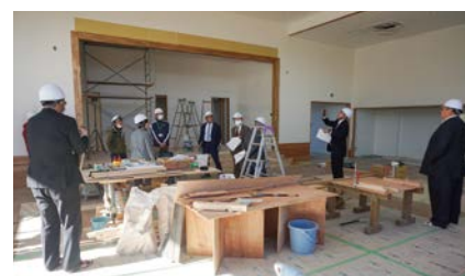
建設中のふたば保育所を視察
