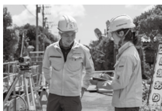
現場を正確に測量
