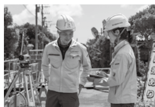
現場を正確に測量
