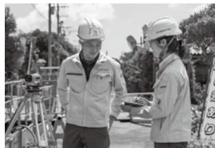
現場を正確に測量
