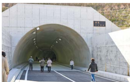
1位／開通した県道銚子海上線・清滝バイパス
