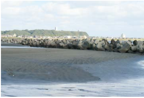
消波ブロックまで砂浜が続いている飯岡海水浴場
