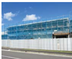
建設中の統合消防分署
