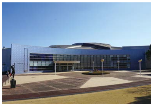
令和5年度から指定管理になった総合体育館
