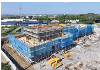
建設が進む中央第二・ゆたか統合保育所(上)と海上・飯岡統合消防分署(下)
