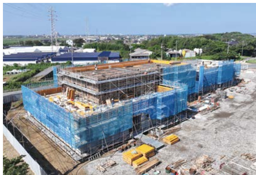
建設が進む中央第二・ゆたか統合保育所(上)と海上・飯岡統合消防分署(下)
