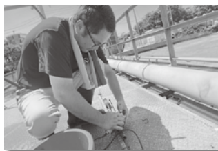
浄化設備機器の修理
