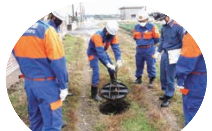
火災に備えて消火栓点検
