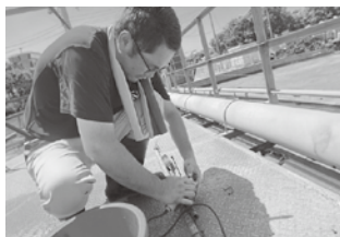
浄化設備機器の修理
