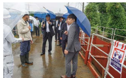
蛇園南地区排水路整備事業現場
