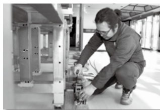
開閉試験用機器の点検
