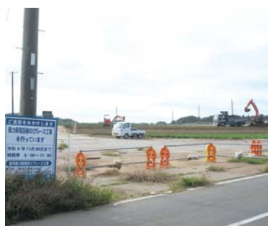
横根地先風力発電工事現場
