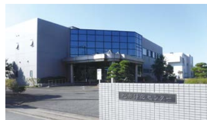
旭市浄化センターを視察
