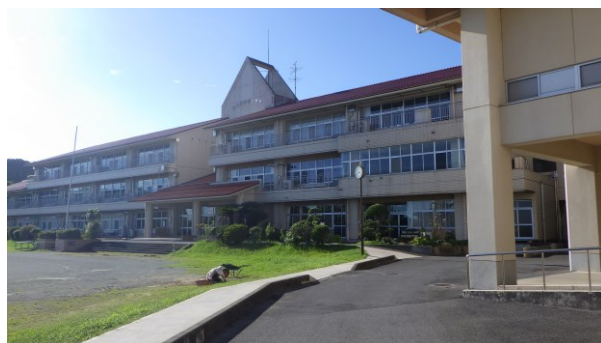
統合先となる古城小学校の校舎外観
