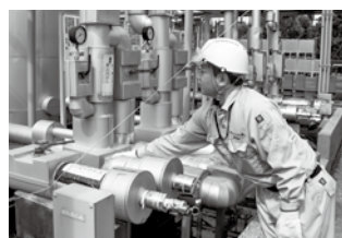
圧力計を見てバルブを調整
