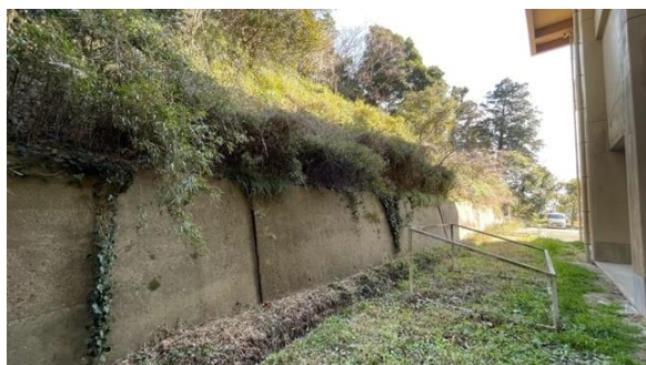
体育館東側法面
