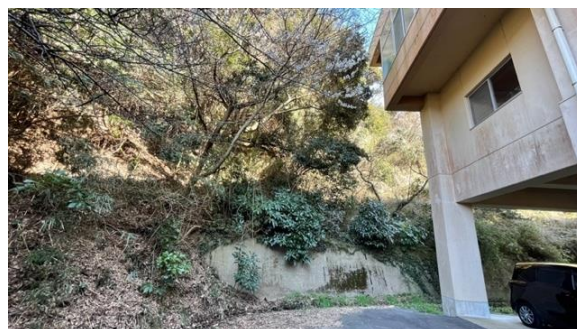
体育館北側法面
