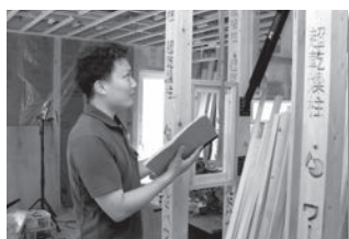
施工状況の確認
