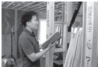
施工状況の確認
