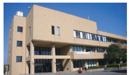
改修予定の海上庁舎
