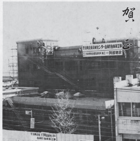
完成間近の合同庁舎
