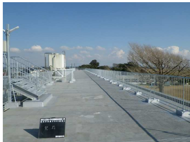
④完成 屋上避難スペース
