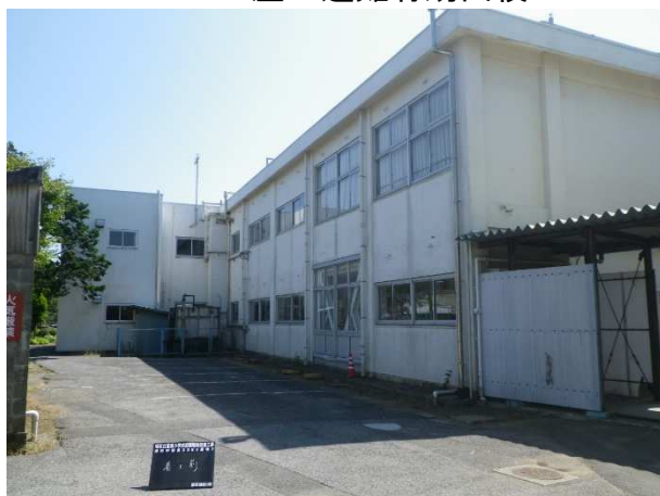
①着工前 避難階段設置箇所
