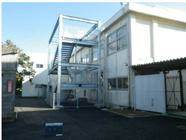
③完成 避難階段設置
