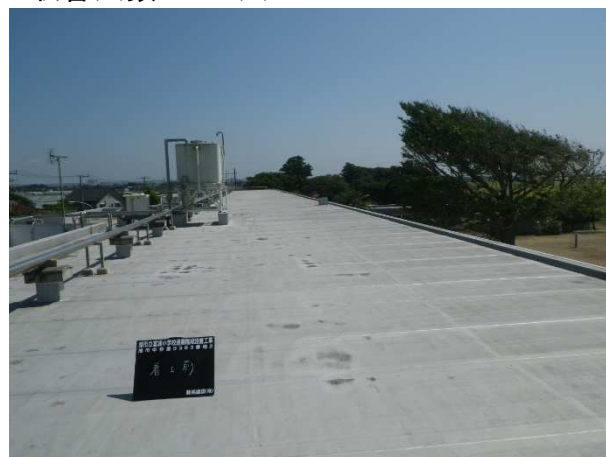
②着工前 屋上避難スペース
