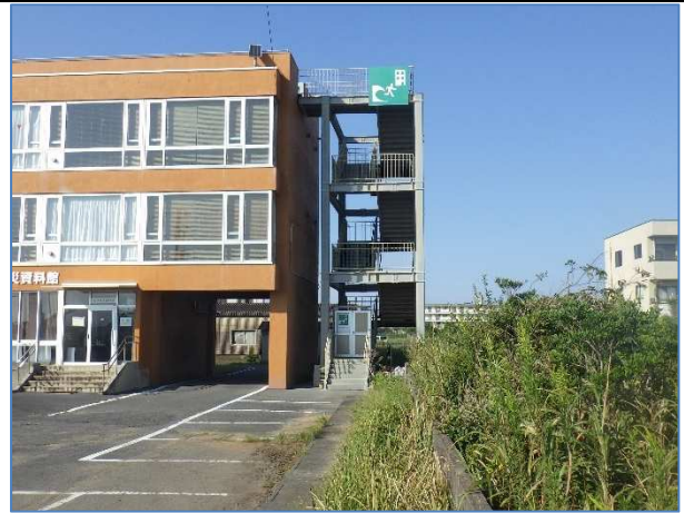
②階段設置後
