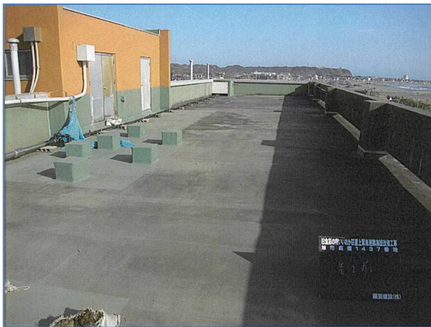
③屋上着工前
